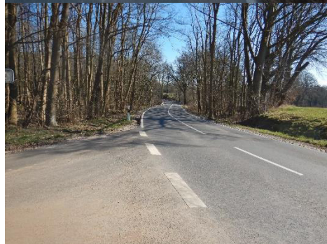
Abb. 1 Netzlücken K 61 Sattenfelde – Rohlfshagen (links); L 226 Grabau – Tönningstedt (SE) (rechts)
